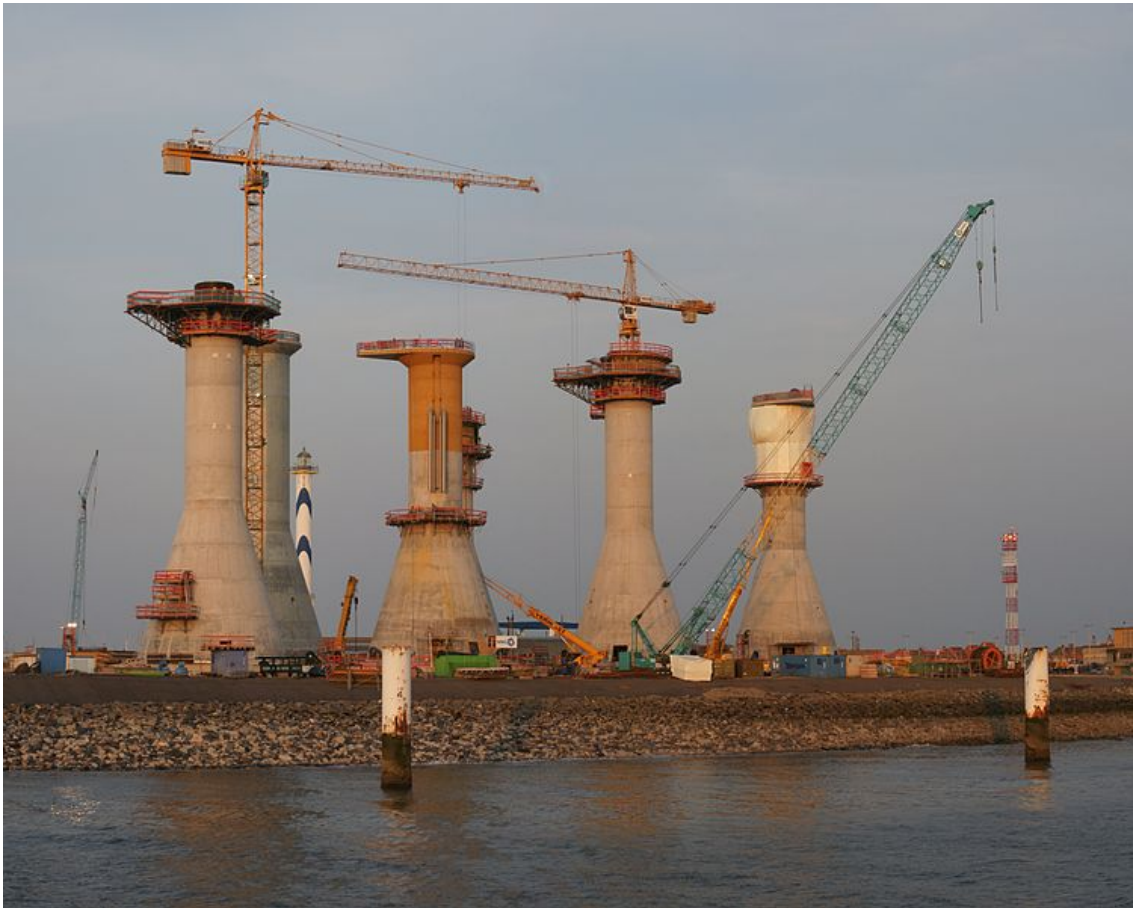
Figura 3: Construcción de las bases de molinos eólicos en Ostende (Bélgica). Fuente: https://commons.wikimedia.org/wiki/File:Windmill_bases_(Oostende_-_from_northwest).jpg
