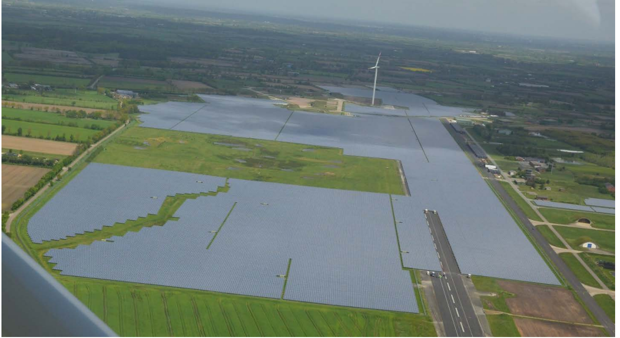
Figura 4: Parque fotovoltaico (FV) en Eggebek (Alemania) de 84 MW. Fuente: https://commons.wikimedia.org/wiki/File:SolarparkEggebek.jpg
