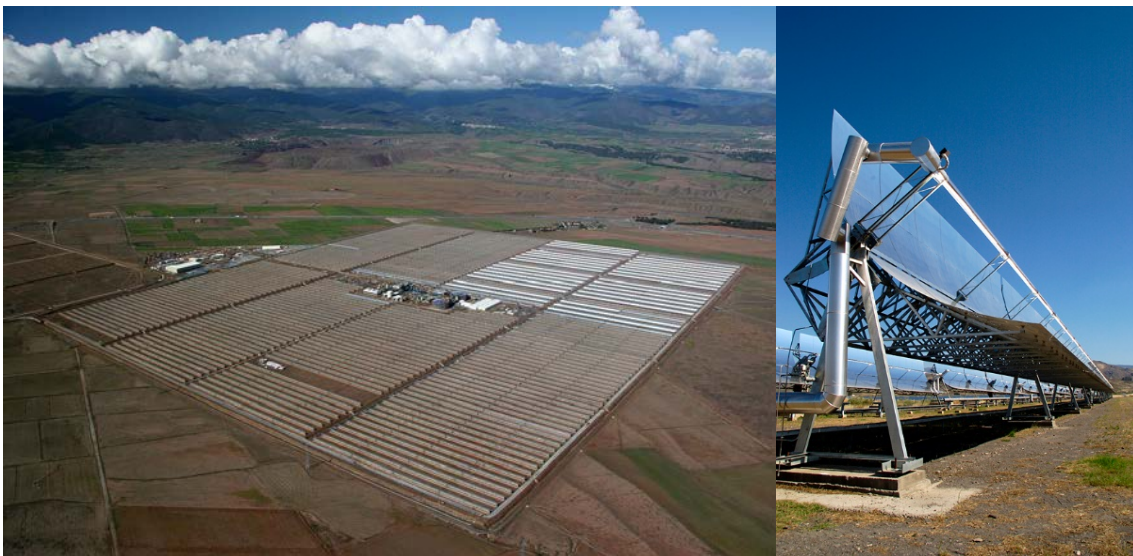
Figura 5: Central termosolar de concentración (CSP) cilíndrico parabólica Andasol (Granada, España). Su situación se escogió por sus buenas condiciones: altiplano elevado con alta radiación solar directa, próxima a una línea de alta tensión de 400 kV, la disponibilidad de aguas de refrigeración provenientes de la falda norte de Sierra Nevada, la proximidad de infraestructuras de carretera y ferrocarril y la disposición de terreno llano sin protección medioambiental. Fuente figura izqda:
